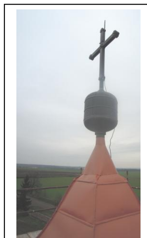
.....a po opravě
