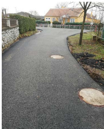
Oprava místní komunikace
