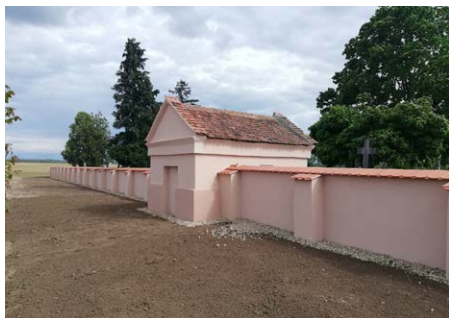
Rekonstrukce hřbitovní zdi
